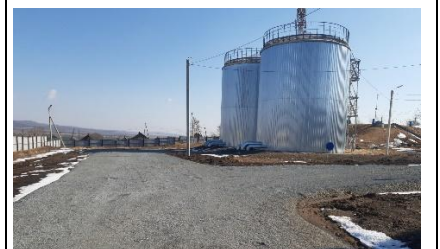
Новая система водоснабжения, запущенная в рамках федерального проекта «Чистая вода»
